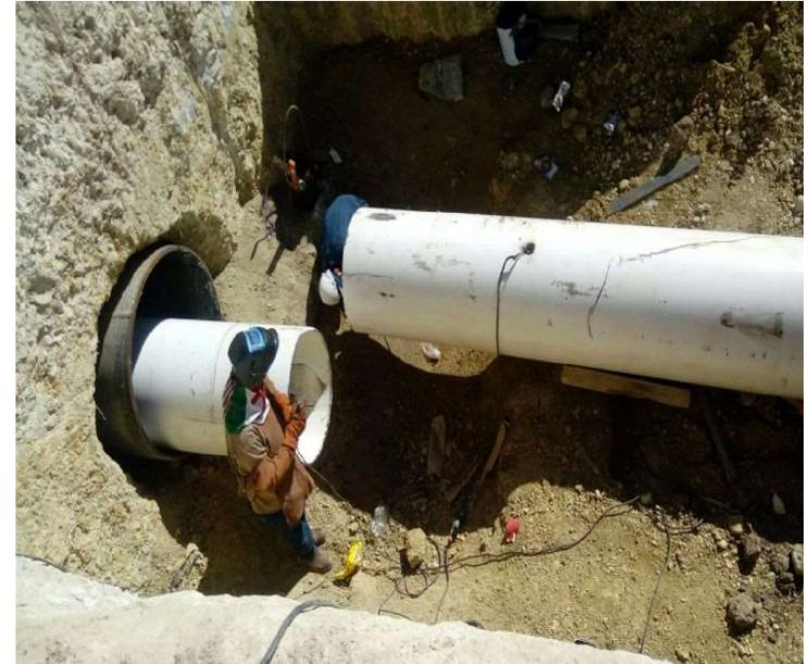
**Instalación de Tubería de 30" Acero, Juárez, N. L.**
